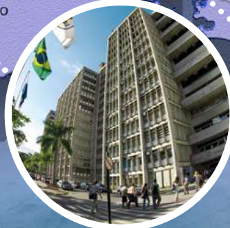
RIO DE JANEIRO Campus Biomédico I, II e III, Campus Francisco Negrão de Lima (Maracanã), Campus Zona Oeste, Casa de Leitura Dirce Côrtes Riedel, Complexo Fonseca Teles (Edifício Pedro Ernesto), Escola Superior de Desenho Industrial (EsdI), Hospital Universitário Pedro Ernesto (Hupe), Instituto de Aplicação Fernando Rodrigues da Silveira (CAp), Instituto de Estudos Sociais e Políticos (Iesp), Policlínica Universitária Piquet Carneiro (PPC)
